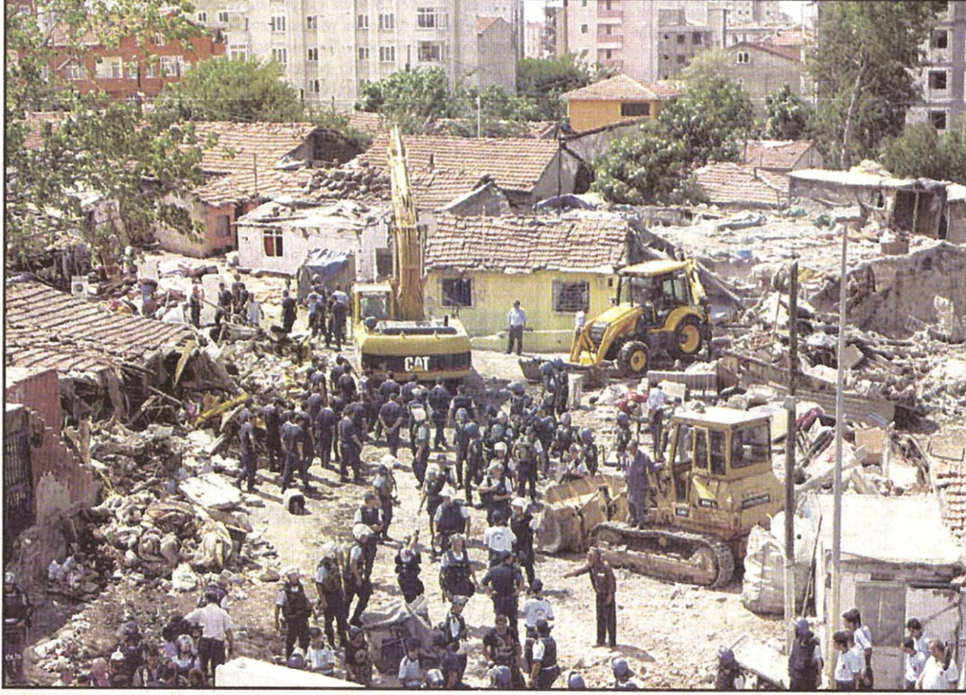
Bazı yıkımlarda olaylar da yaşanıyor... Son olarak Küçükbakkalköy'de yapılan yıkımda olaylar çıktı.....
